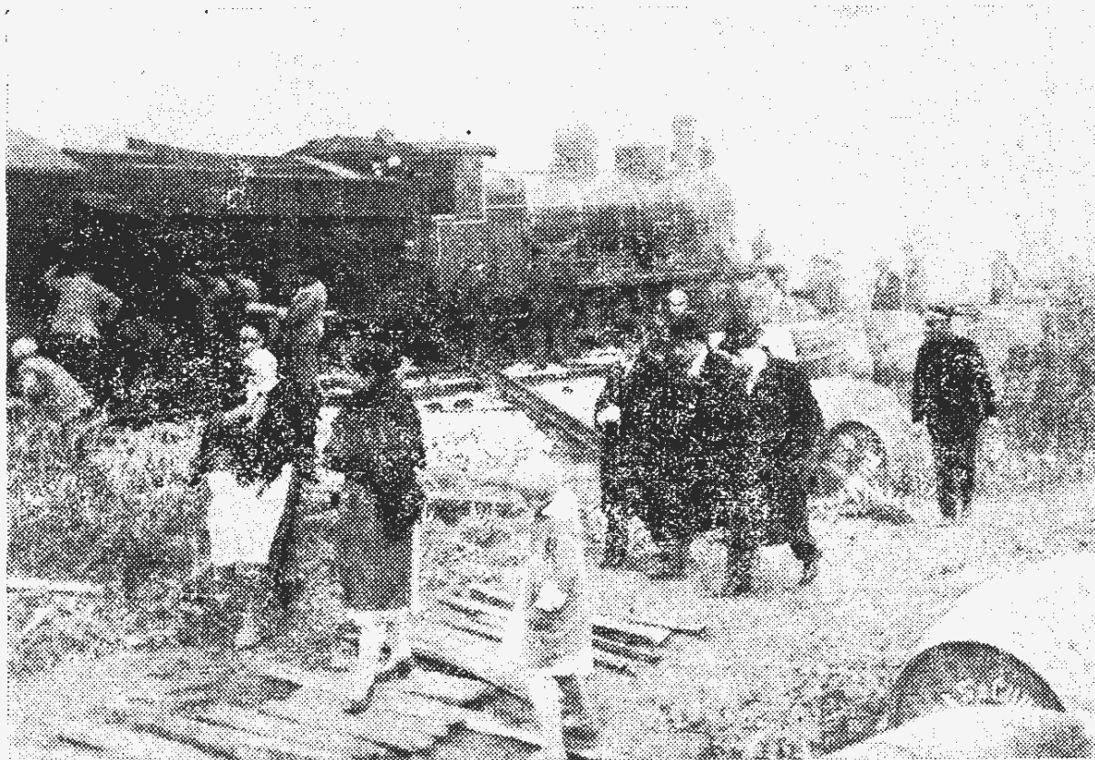
O ministro das Obras Publicas chega ao local do sinistro, a fim de avaliar a extensão do de e presenciar os trabalhos de reparação da via
